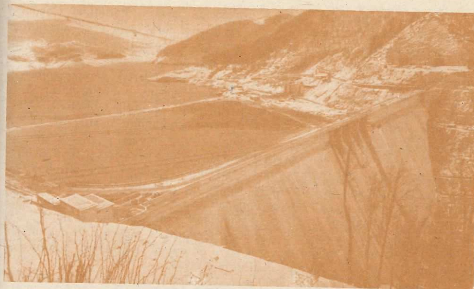
Barajul hidrocentralei de la Bicaz
